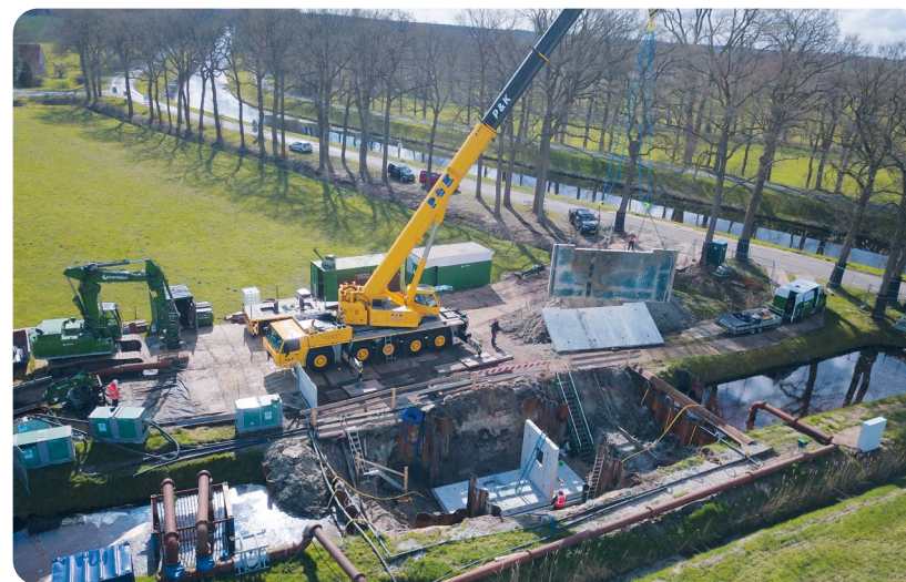
Figuur 14: Gemaal Coehoorn, pilot prefab en losmaakbaar bouwen in geopolymeerbeton
