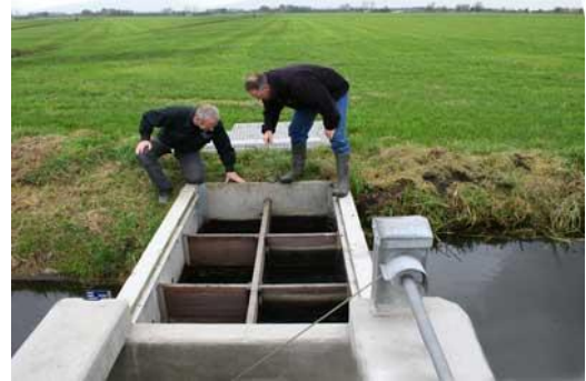
Vispassage als samengesteld kunstwerk met kantelstuw in polder Mastenbroek.
