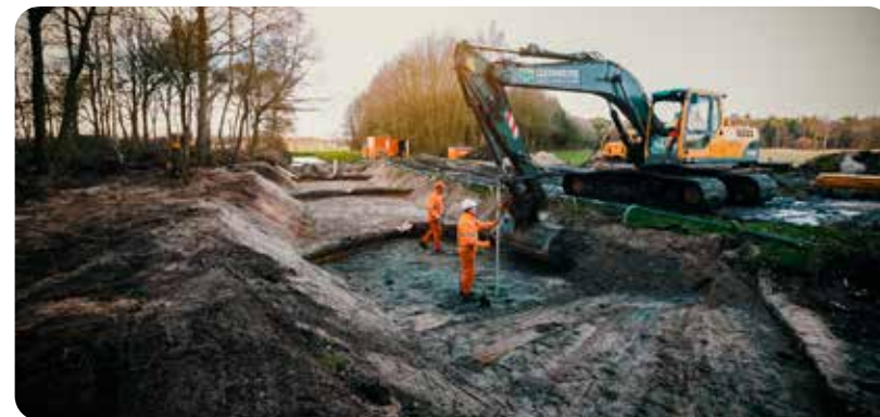
Figuur 6: Aanleg vispassage Marswetering
