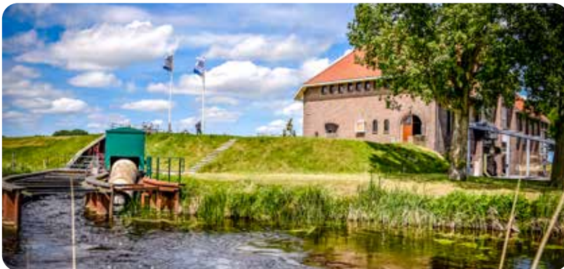
Figuur 5: Waterinlaat gemaal Stroink
