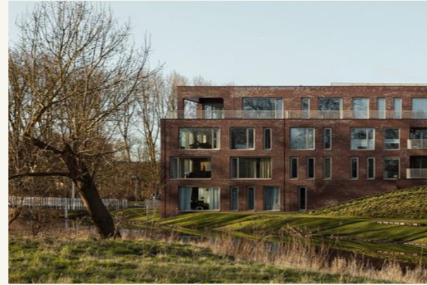
De bovenste verdieping is teruggelegen.
