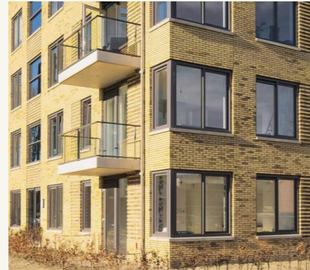
Zorgvuldige detaillering van de gevel.
