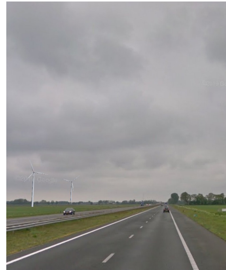
turbines op 500 meter van de A7
