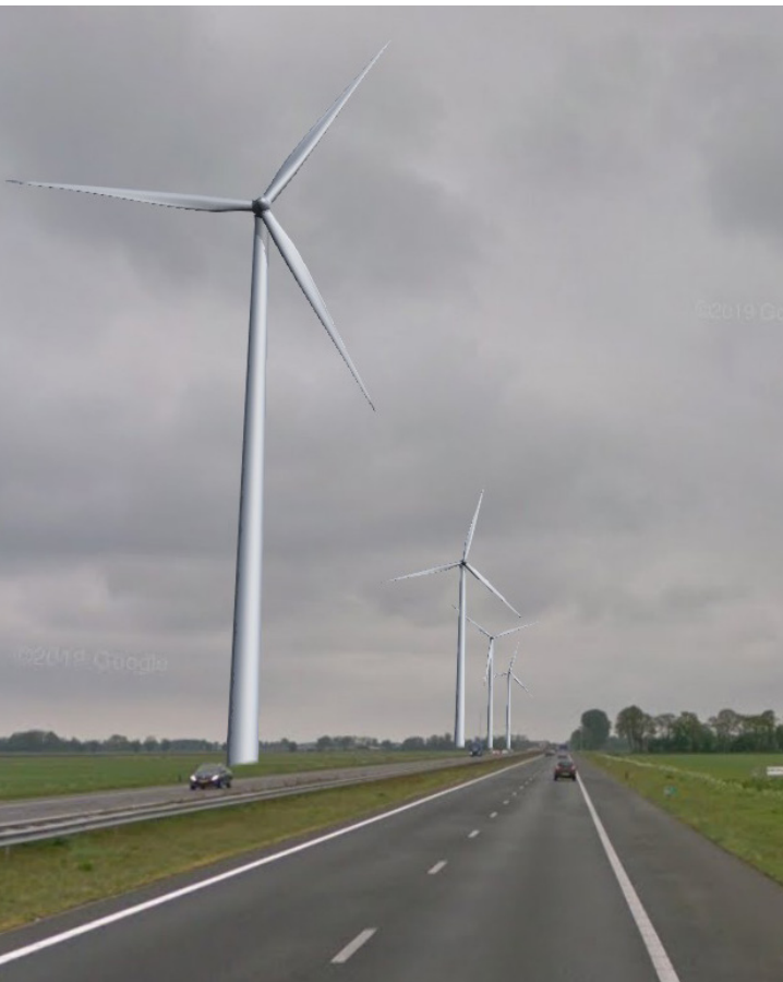
turbines op 50 meter van de A7
