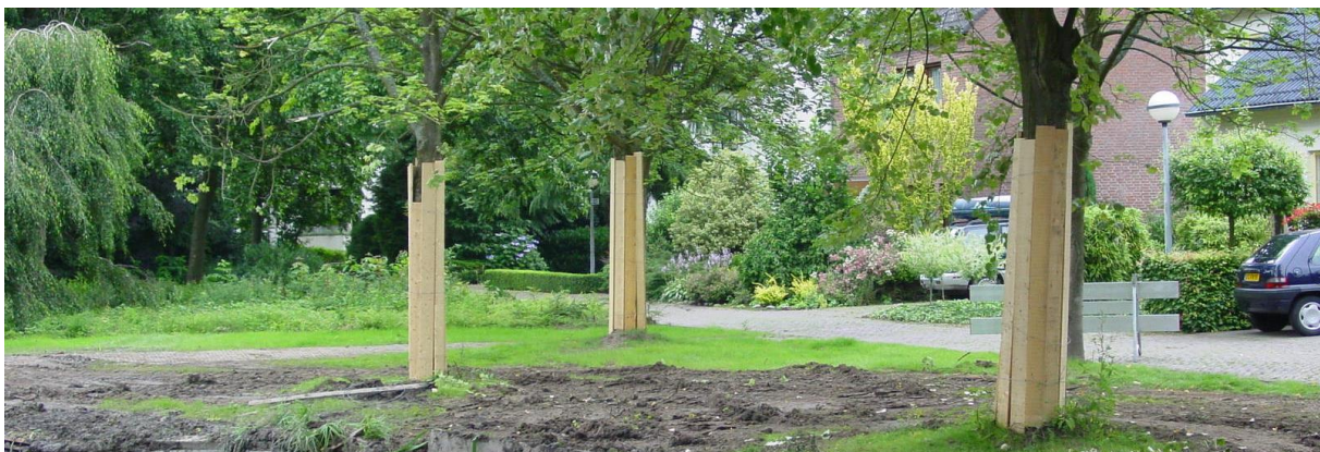
Bescherming van bomen tijdens de uitvoering van werkzaamheden voorkomt schades (foto BTL Advies)
