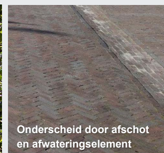
Gebruik van roodbruine klinkers, onderscheid door bijv. legverband en/of kleur
