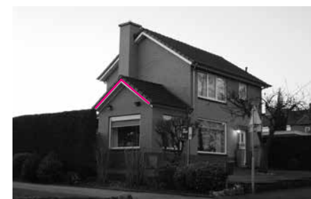
Kapvorm, architectuur, materiaal, kleur en detaillering afgestemd op het hoofdgebouw. Duidelijk ondergeschikt en gerelateerd aan de maat en schaal van het hoofdgebouw.
