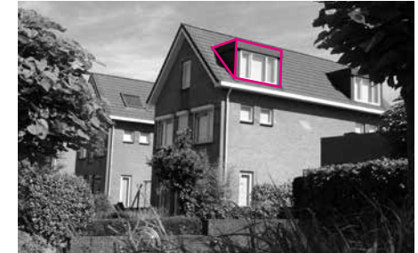
In onderste deel van het dakvlak.
