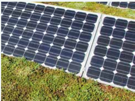
Combinatie van zonnepanelen en vegetatiedak.
