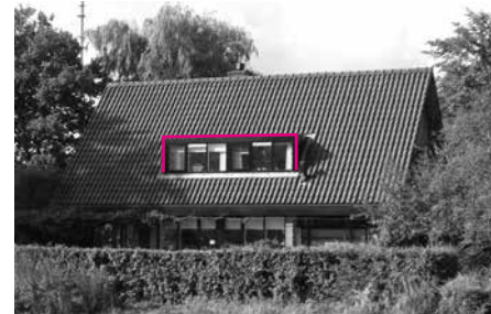
In onderste deel van het dakvlak.
