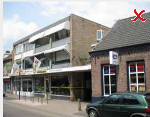
Nieuwbouw sluit niet aan op aanwezige bebouwing qua maat en schaal.
