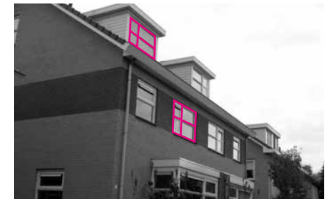
Kozijnindeling afgestemd op de indeling van de gevelkozijnen van het hoofdgebouw.
