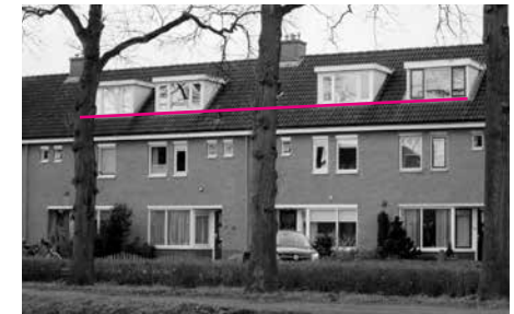
Afgestemd op bestaande dakkapellen op het bouwblok.
