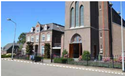
Appelteren: de bebouwing staat met de voorkant naar de dijk gericht en ligt op hetzelfde niveau als de weg.
