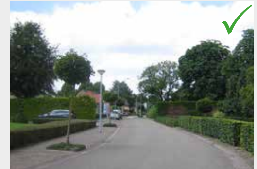
Verbijzondering van goten en parkeerstrook. Elementenverharding voor de rijbaan was nóg beter geweest.
