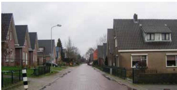
Oude Maasdijk in Dreumel: een oud bebouwingslint dat steeds verder verdicht is
