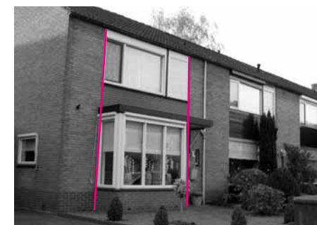
Geplaatst in bestaand raamkozijn.
