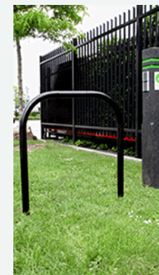
Oplaadpaal voor elektrische fiets.
