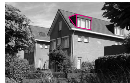
In onderste deel van het dakvlak.
