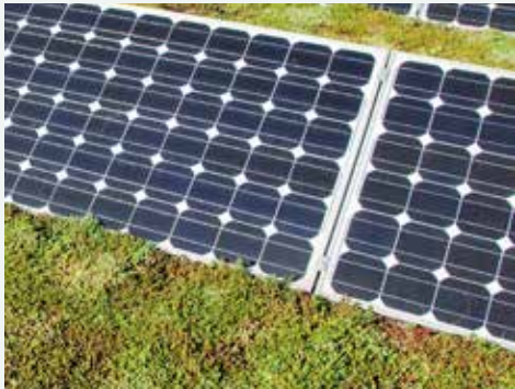
Combinatie van zonnepanelen en vegetatiedak.
