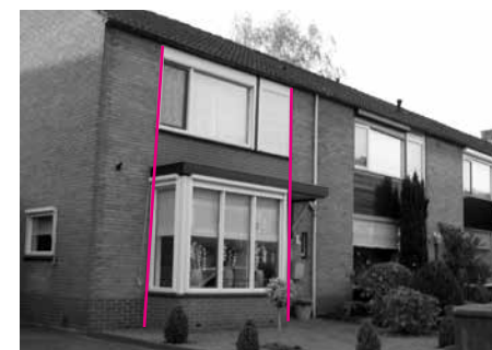
Geplaatst in bestaand raamkozijn.
