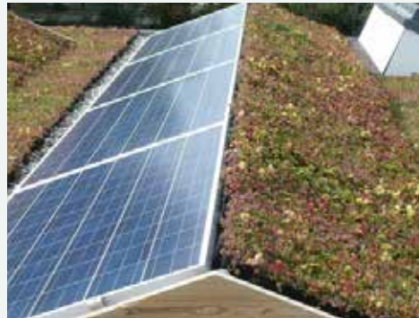
Combinatie van zonnepanelen en vegetatiedak.
