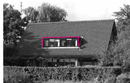
In onderste deel van het dakvlak.
