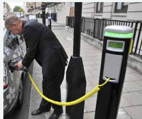
Oplaadpaal voor elektrische auto.
