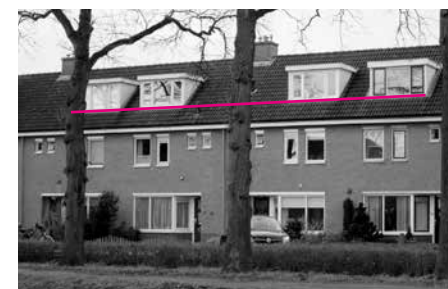
Afgestemd op bestaande dakkapellen op het bouwblok.
