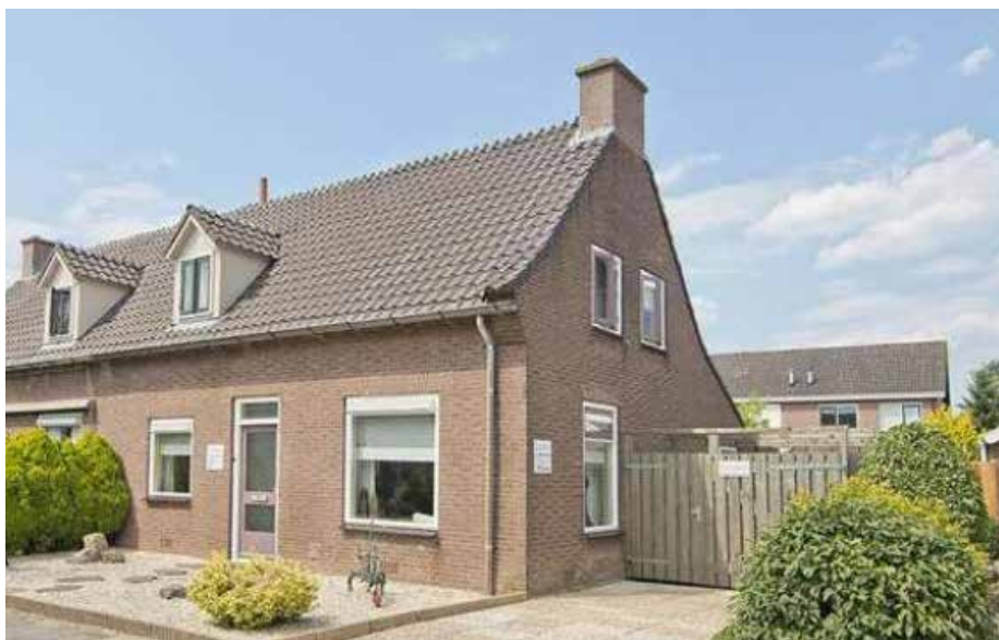
vroeg-naoorlogse sociale woningbouw aan Willibrordusstraat
