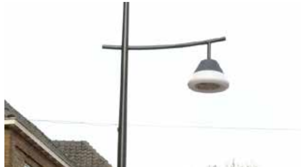
Dorpse verlichtingsarmaturen versterken het historische karakter van de Dorpsstraat.
