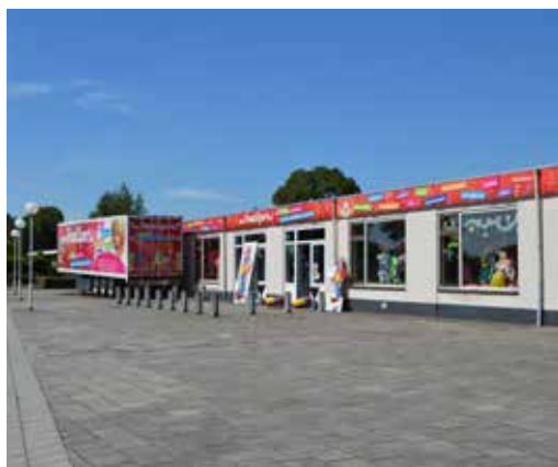
Het bedrijfspand aan de Grachtstraat valt nu erg op. Bij herontwikkeling kan de locatie beter aansluiten bij de ruimtelijke karakteristiek van de omgeving.
