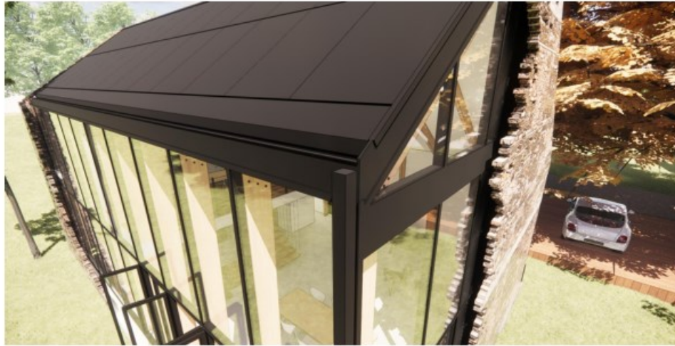
Detail van de goot en HWA zonder zonwering
