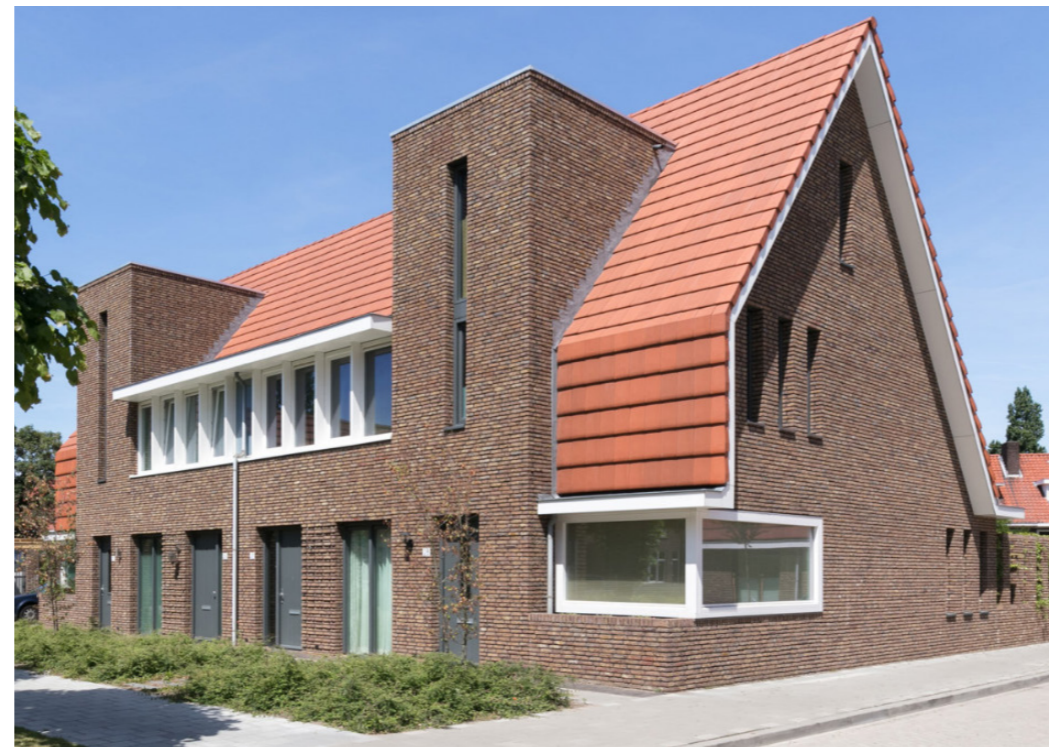
Voorbeeld van verbijzondering kopwoningen door optrekken deel van topgevel en omzetten van het bloemkozijn in de zijgevel
