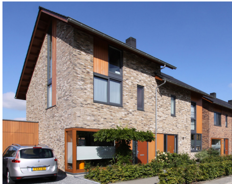
Voorbeeld van verbijzondering eindwoning door optrekken kap en goothoogte in combinatie met verspringsing rooilijn
