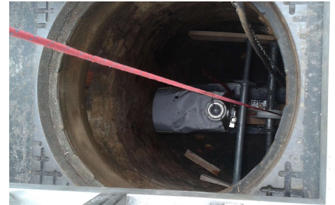
Relinen, het inbrengen van een kous
