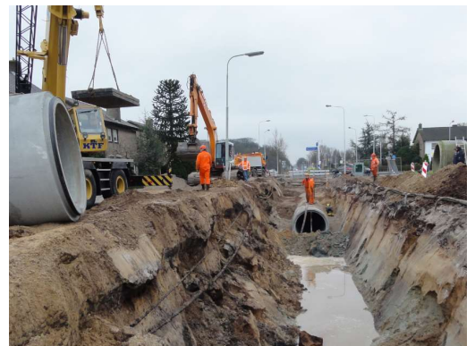
Aanleg regenwaterriool tijdens reconstructie Steenwijkerweg
