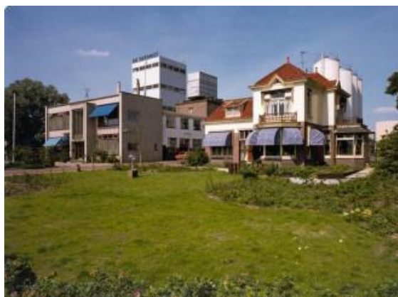
Zuivelfabriek met directeurswoning, ca, 1980
