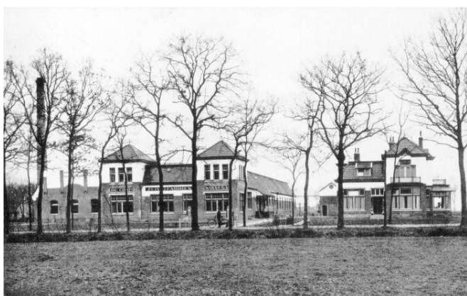
Zuivelfabriek met directeurswoning in 1913
