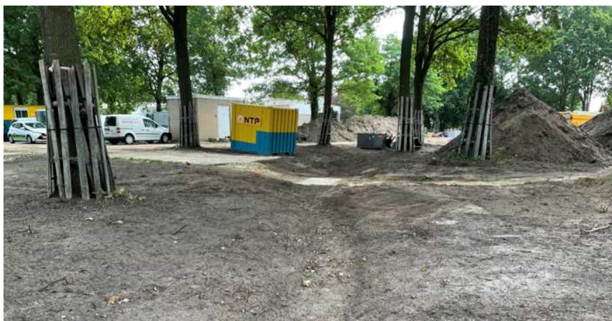
Figuur 3 Aanleg wadi Roerganger Enter (2023)
