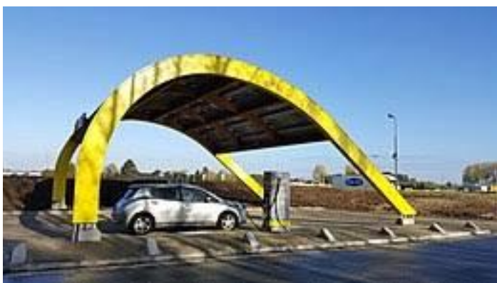
Figuur 3: Voorbeeld Snellaadstation langs snelweg
