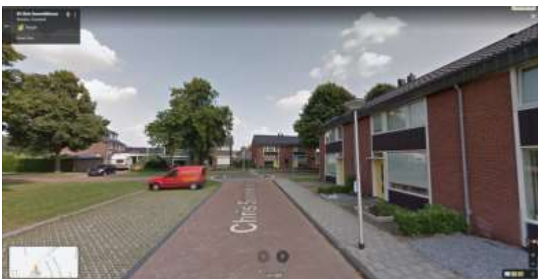
Bestaande situatie in de Chris Soumokilstraat: parkeerplaatsen met graskeien
