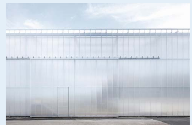
Gesloten gevels, Streetmekka Viborg (bron: EFJEKT)
