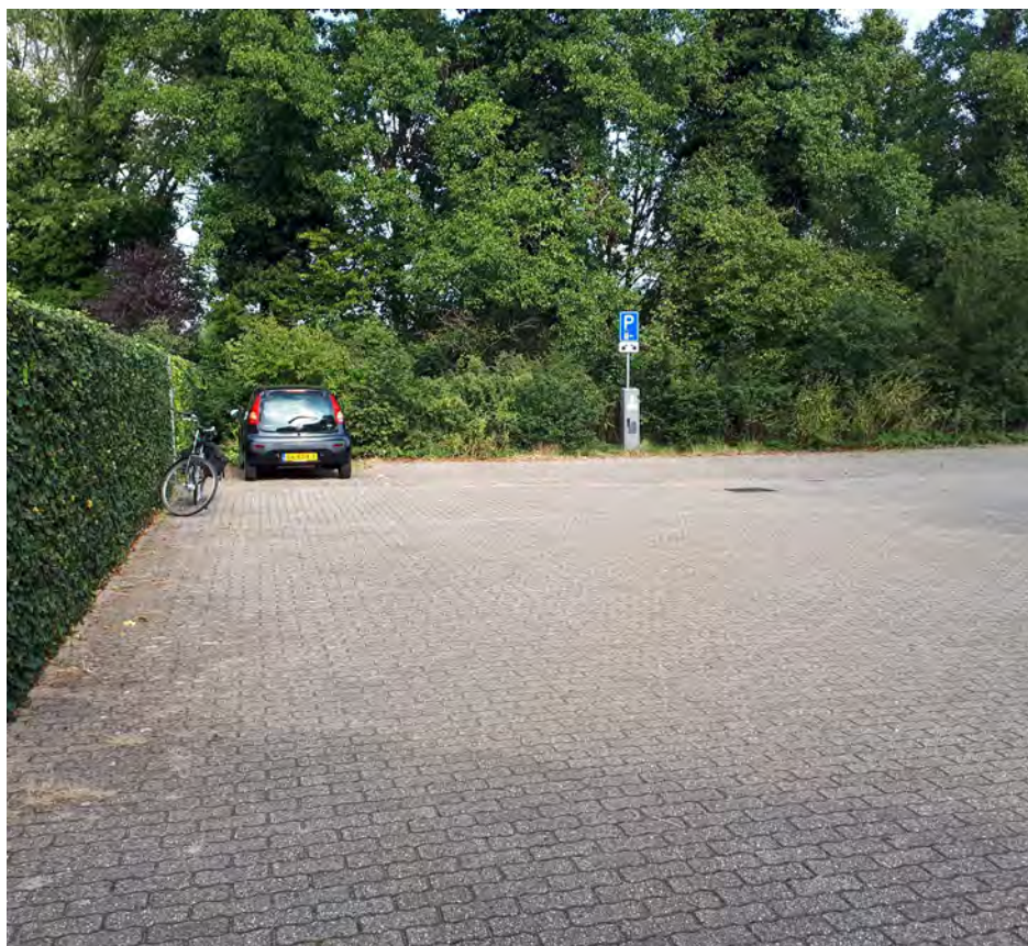
Bargerstegge - grote hoeveelheid verhard oppervlak
