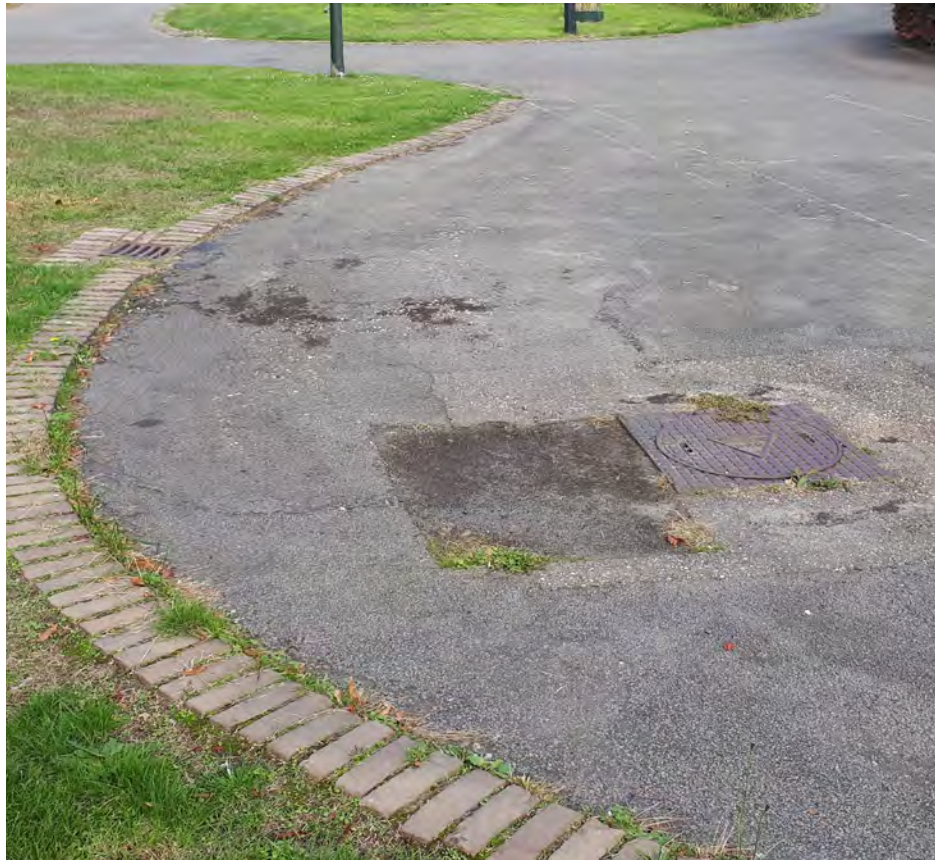
Barger Kempke - asfaltverharding aan vervanging toe
