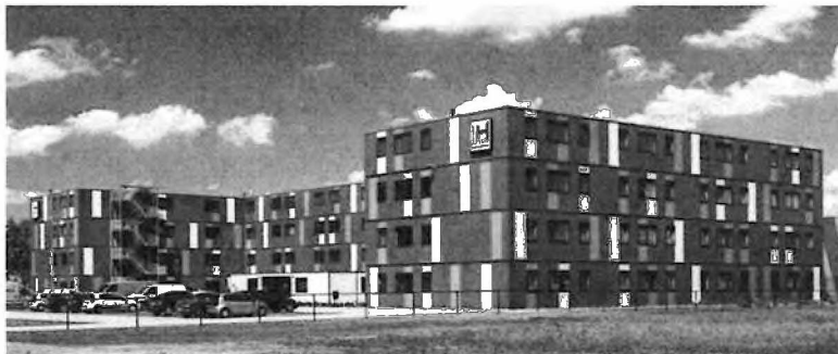
Animatie bouw Migranten hotel Waalwijk door 5.1.2,e
