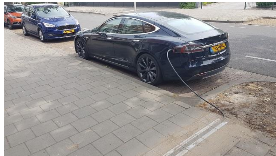
Figuur 7. Voorbeeld van de toepassing van een kabelgoottegel (bron: Struyk Verwo Infra).
