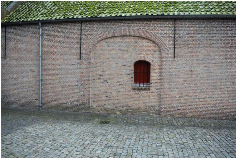
Dichtgemetselde opening onder segmentboog met houten luik.
