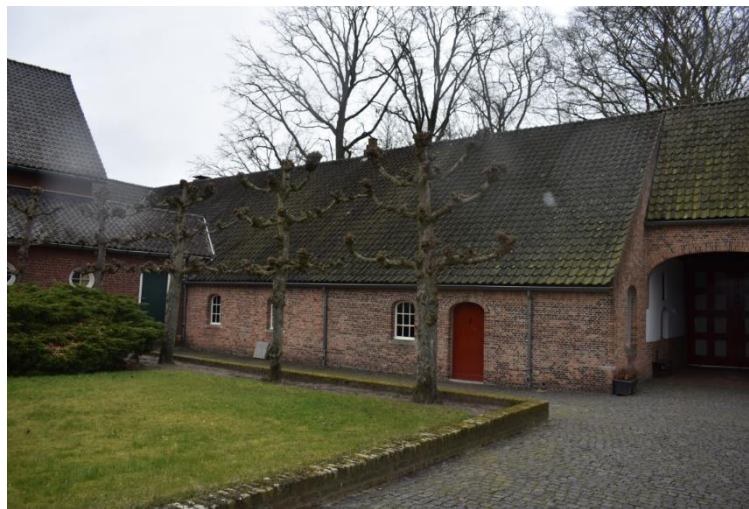
Linkerdeel van de achtergevel.
