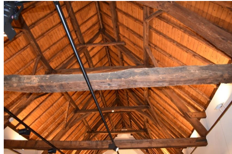
Constructie van Hollandse spanten.
