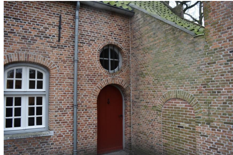
Loopdeur met rondlicht en dichtgemetselde deur in aanbouw.
