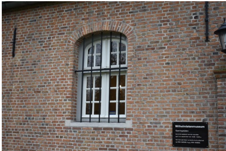
Houten kozijn met stolpramen onder segmentboog.
