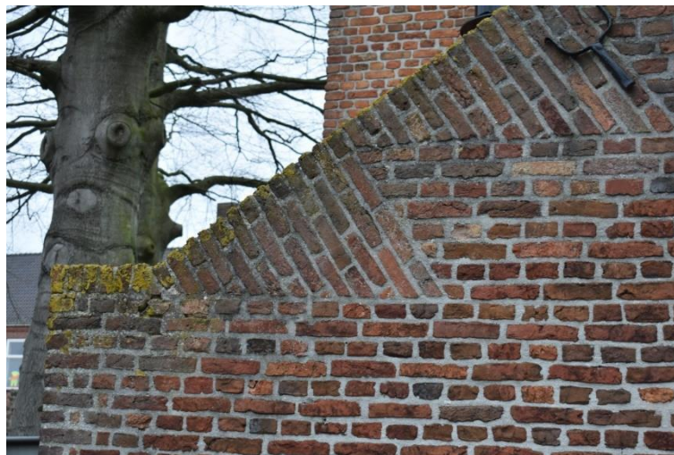
Latere vlechtingen in metselwerk.
