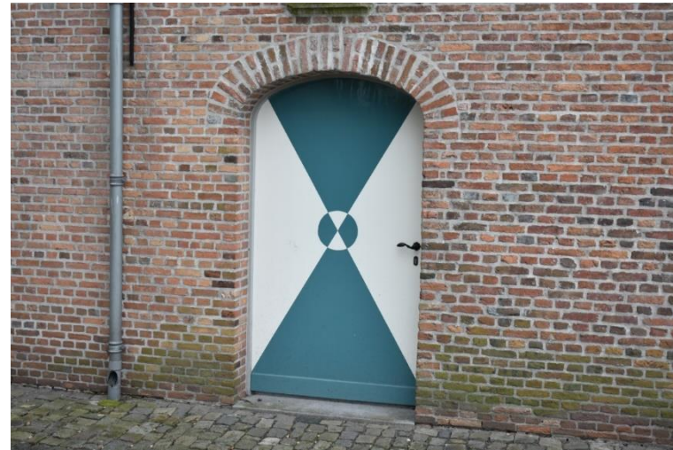
Loopdeur onder segmentboog.
