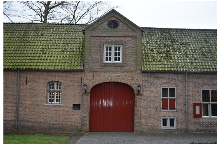
Middenrisaliet met entree en onderdoorgang.
