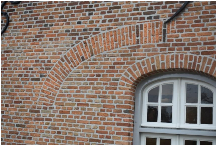
Segmentboog in metselwerk.
