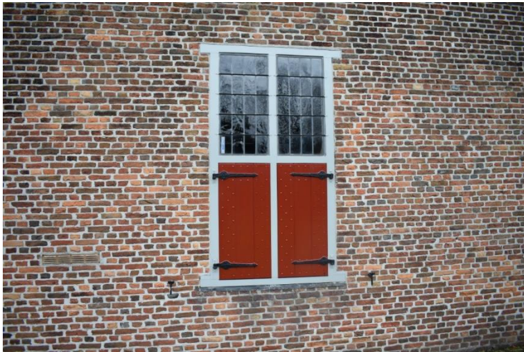
Gereconstrueerd kloosterkozijn met glas-in-lood.
