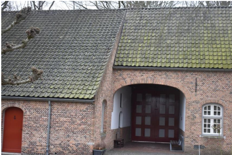
Onderdoorgang onder segmentboog.
