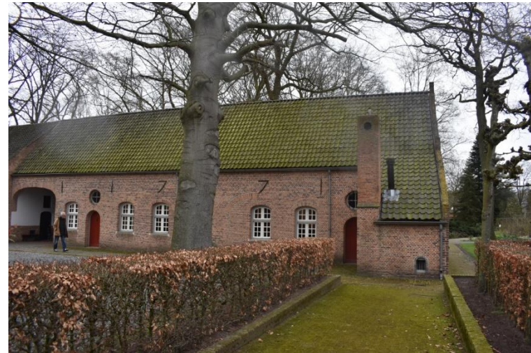
Overzicht rechterdeel van de achtergevel.
