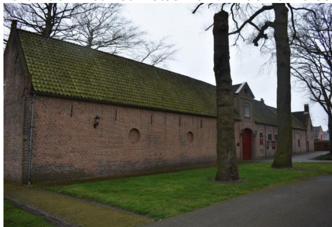
Overzicht linker deel voorgevel.
