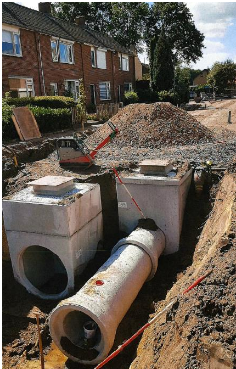
Figuur 11 Nieuwe riolering in de Demerstraat, Huijbergen
