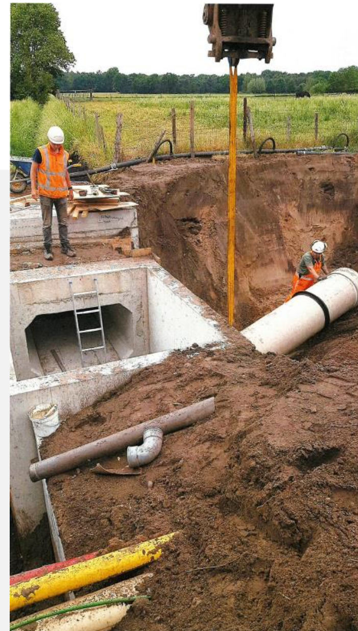
Figuur 3 De aanleg van een HWA-riool in de Demerstraat, Huijbergen (2022)
