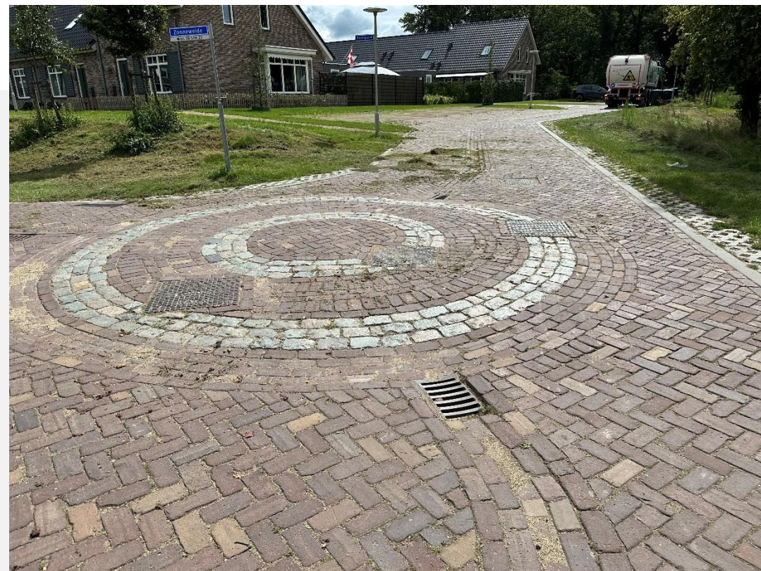
Figuur 15 Een verlaagde middenberm voorkomt wateroverlast op straat
