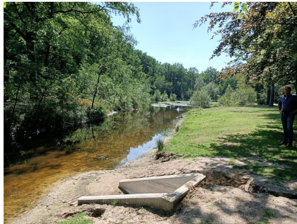
Figuur 5 Hemelwateroverstort van de Sparrenlaan op de Eendenvijver, Putte
