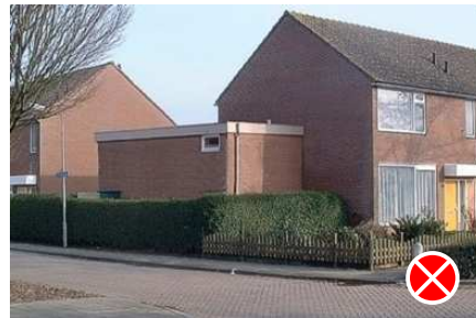
Fig. 2: zijaanbouw te hoog
