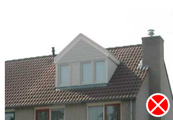
Fig. 13: vormgeving sluit niet aan op de stijl van de woning
