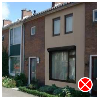
Fig. 10: nog meer verstoring door afwijkend materiaal voor kozijnen en gevelvlak
