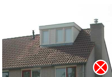
Fig. 12: te hoog op het dak, profiel van de woning wordt aangetast
