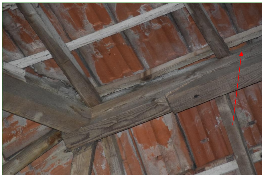
Op twee verschillende plekken in het dak kropen Gewone grootoorvleermuizen weg.
