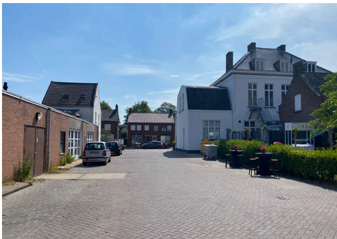
Figuur 3.9: Raadhuisstraat gezien vanaf achterterrein
