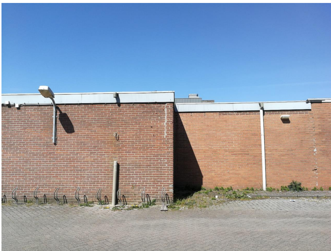
Figuur 3 Achterzijde van de laagbouw met winkels.
