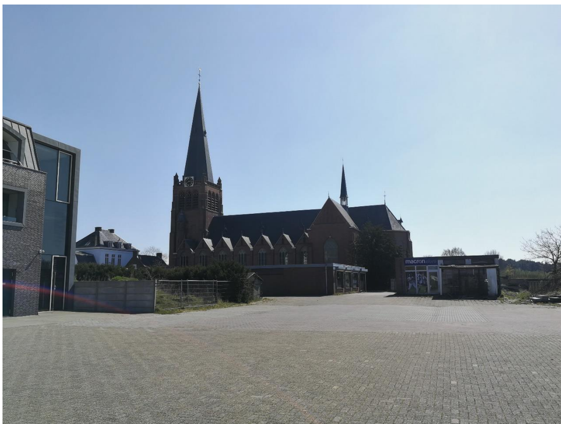
Figuur 2 Achterzijde van het projectgebied, bekeken vanaf het westelijke parkeerterrein in de richting van de Onze Lieve Vrouw Hemelvaartkerk.
