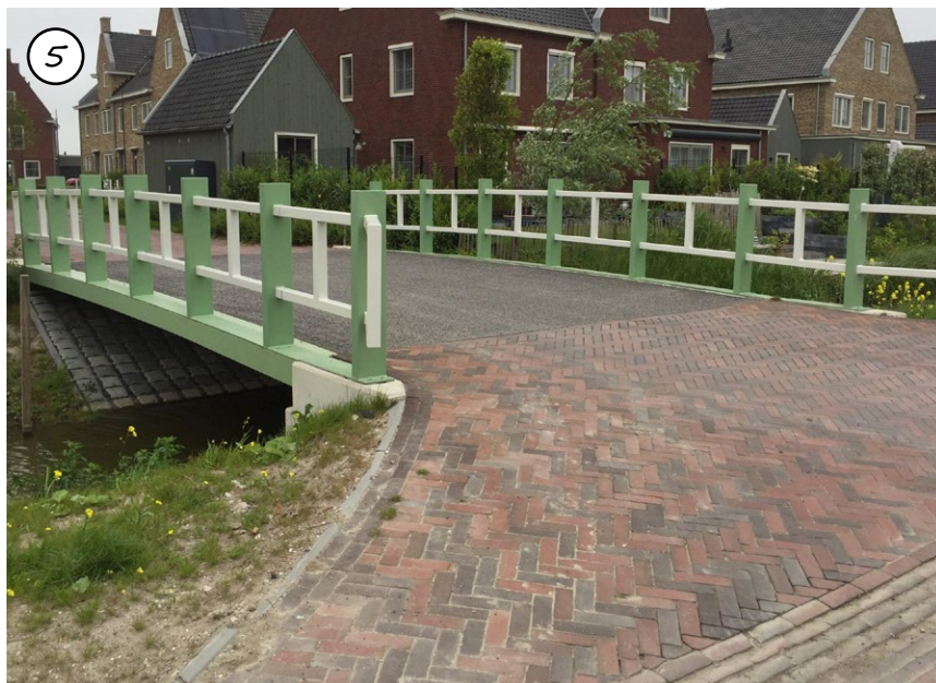
Figuur 58: Onderscheid in materiaal tussen overbrugging en Opmeerder Wuiver
