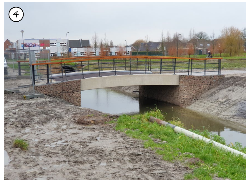
Figuur 53: Subtiële overbrugging over de twee greppels aan de Opmeerder Wuiver
