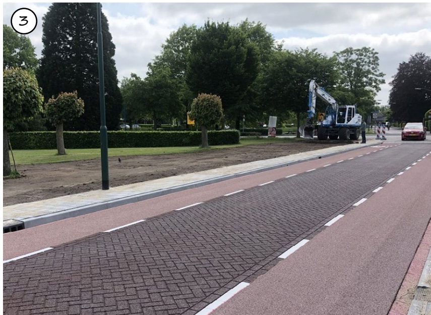
Figuur 54: Asfalt met streetprint als materialisering van ontsluitingsweg
