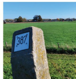
Dijkpaal ter hoogte van het plangebied is referentiepunt voor de bepaling van het 'profiel van vrije ruimte' (PVR)
