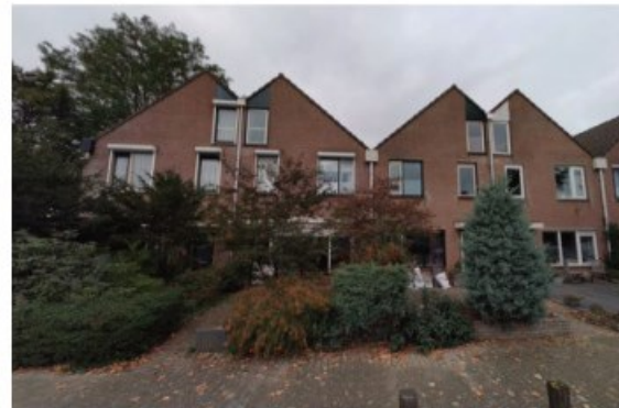
Bingerdensedweg, rijtjeswoningen met topgevels
