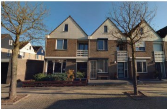
Beumerskamp, rijtjeswoningen met topgevels
