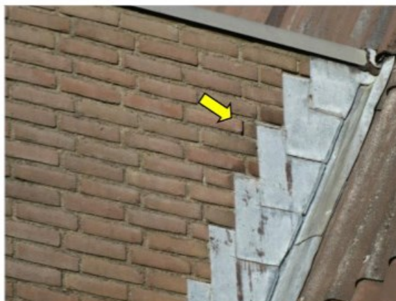
Figuur 5.6 Open stootvoegen die toegang verlenen tot de spouw.
