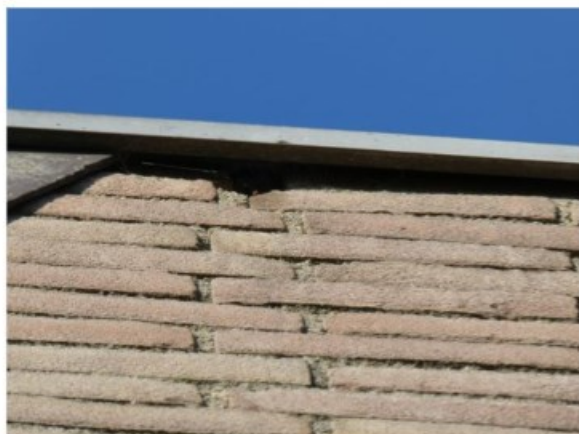
Figuur 5.5 Opstaande dakrand die toegang biedt tot ruimtes onder het dak.
