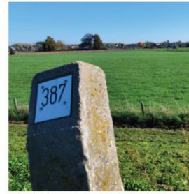
Dijkpaal ter hoogte van het plangebied is referentiepunt voor de bepaling van het 'profiel van vrije ruimte' (PVVR)
