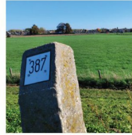
Dijkpaal ter hoogte van het plangebied is referentiepunt voor de bepaling van het 'profiel van vrije ruimte' (PVVR)
