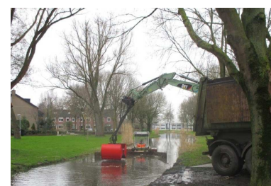
Baggeren in stedelijk gebied
