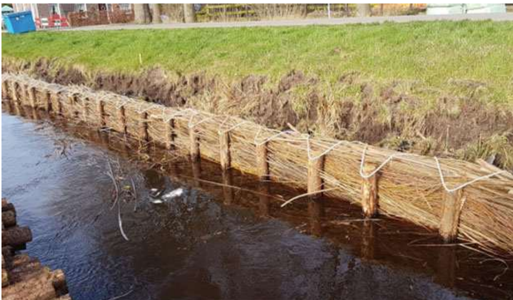
Beschoeiing van palen en gevlochten wilgenhout
