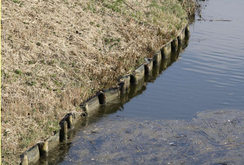
Beschoeiing van palen met doek
