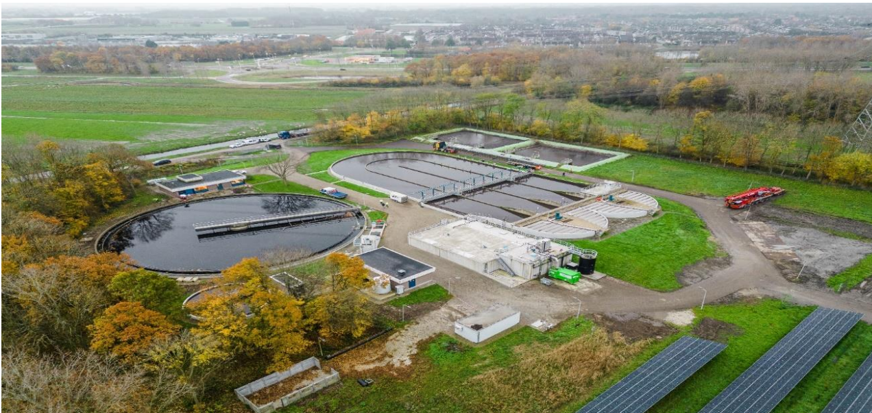
Foto: Levering Ruimerbrug rwzi Oostvoorne
