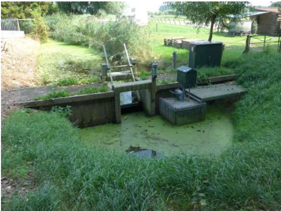
Figuur 13: Inlaatpomp 'Rietveld' met bijbehorende stuw 'R'
