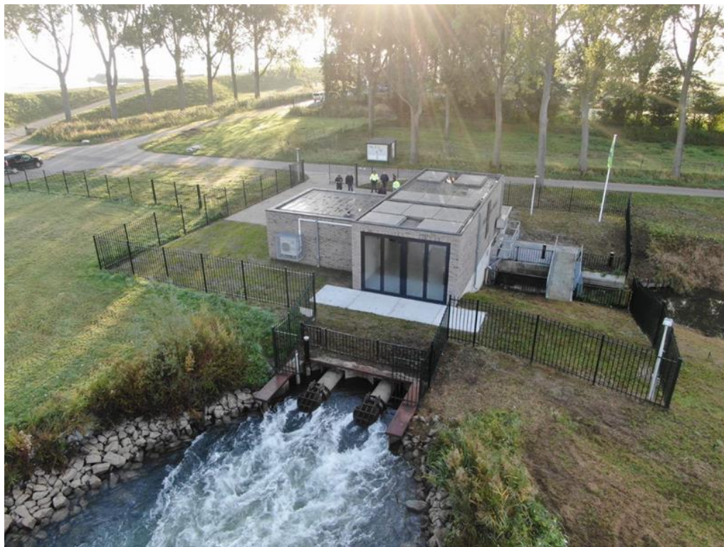
Foto: Inlaatgemaal Van Pallandtpolder Goeree-Overflakkee
