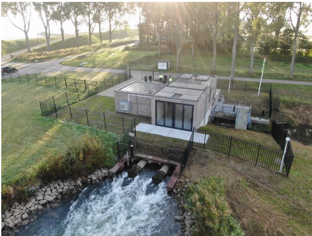
Foto: Inlaatgemaal Van Pallandtpolder Goeree-Overflakkee
