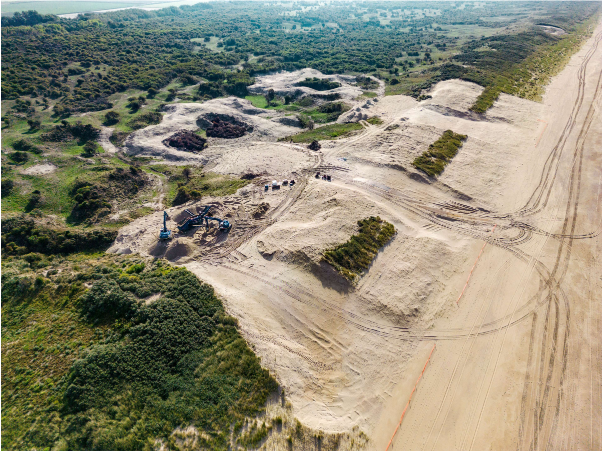
Figuur 1: Een luchtfoto van de aanleg van de kerven
