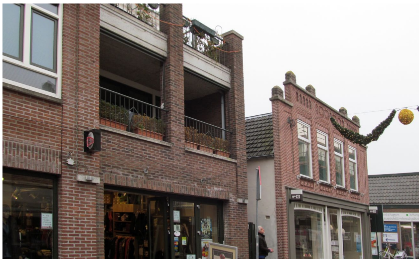
De nieuwbouw is afgestemd op de belending
