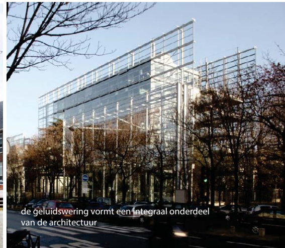
de geluidswering vormt een integraal onderdeel van de architectuur
