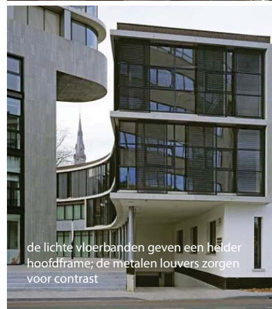
de loggia's creëren diepte en de invulling (houten louvers) contrasteert met de witte vloerband
