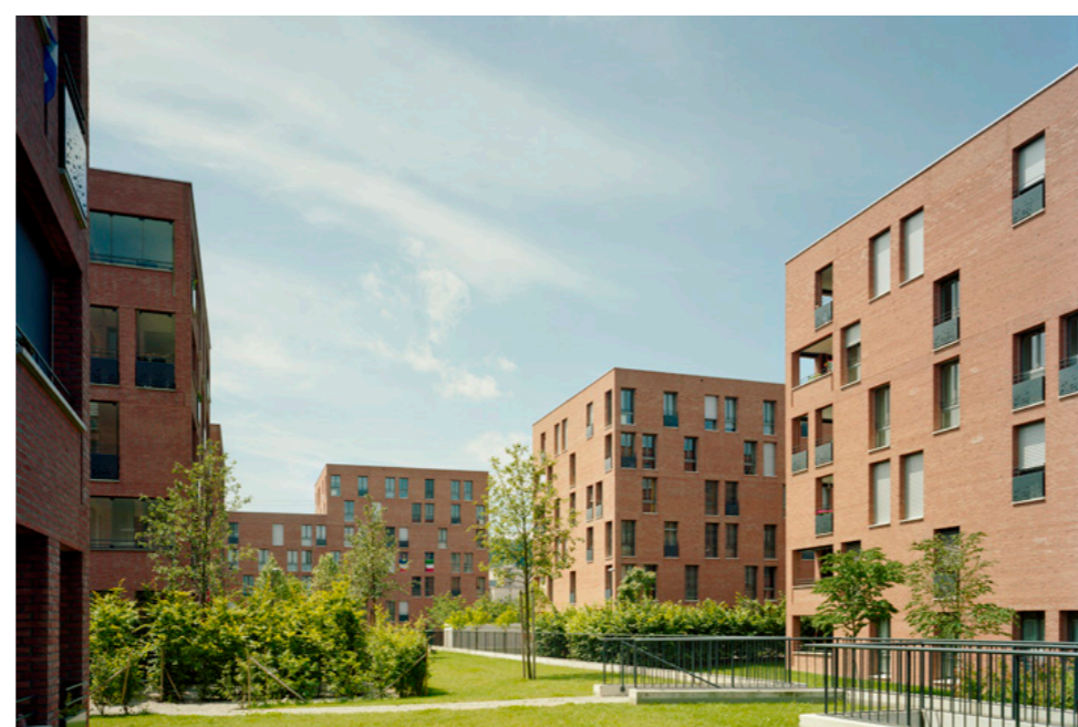
Rugacherm - Baumschlager Eberle Architekten
