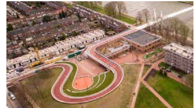
Fietsroute over het dak van een schoolgebouw, Utrecht
