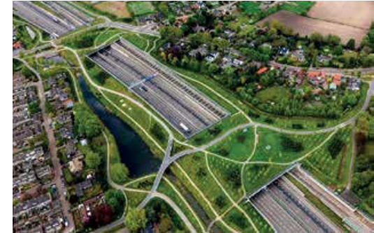
Landschappelijk park over snelweg, stadsduct Valdijk Breda
