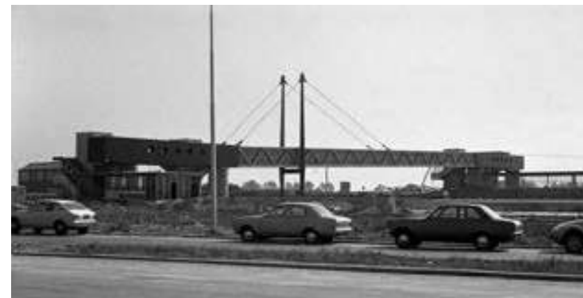
Oorspronkelijke tuibrug uit 1973
