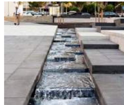
Watercascades maken afvoer hemelwater zichtbaar
