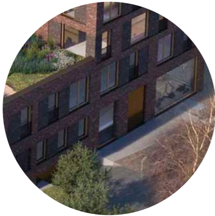
in- en uitrit parkeergarage
